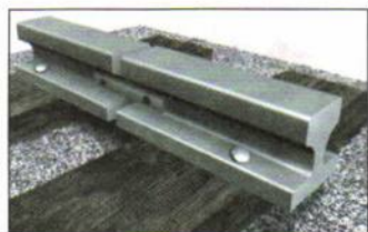
Стыки железнодорожных рельсов
